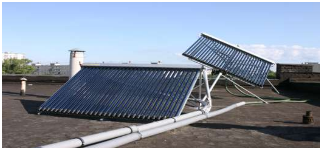
Рис. 2. Експериментальна система для нагріву води з використанням сонячних колекторів розроблена з добувачем та сконструйована в УкрДГРІ. (Патент на винахід № 95687, зареєстровано в Державному реєстрі патентів України на винаходи 25.08.2011 р.)
