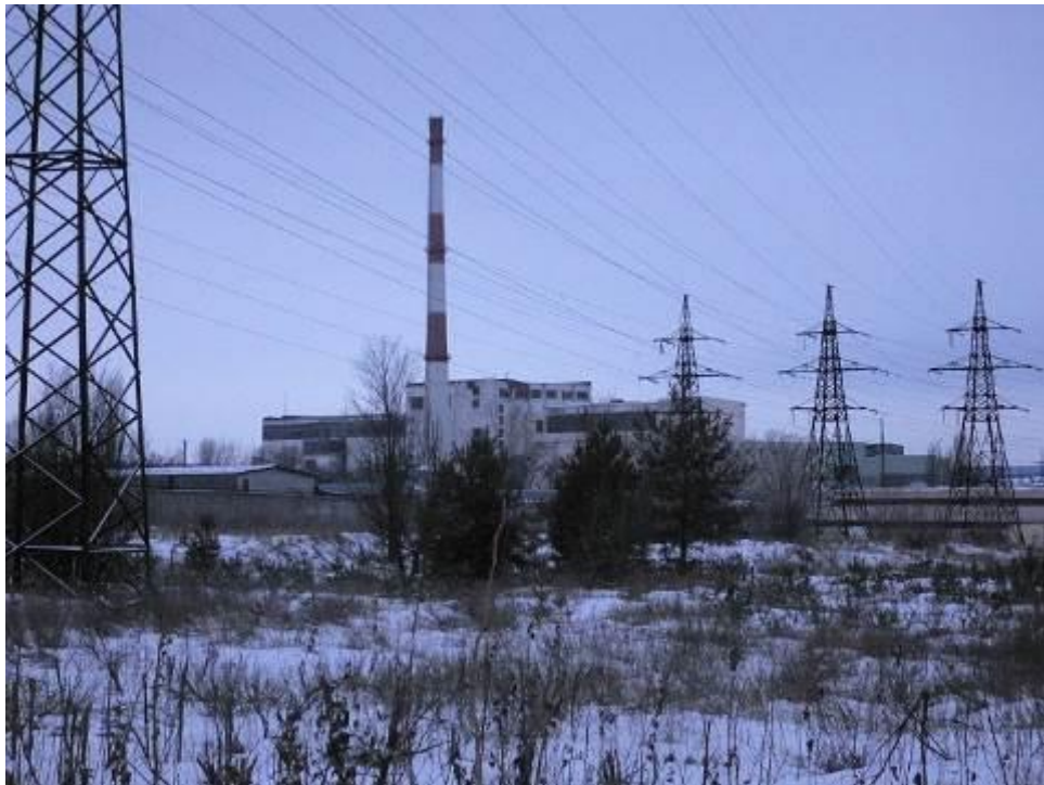
Рисунок 1.13 – 1, 2 енергоблоки Нововоронежской АЕС [101]
